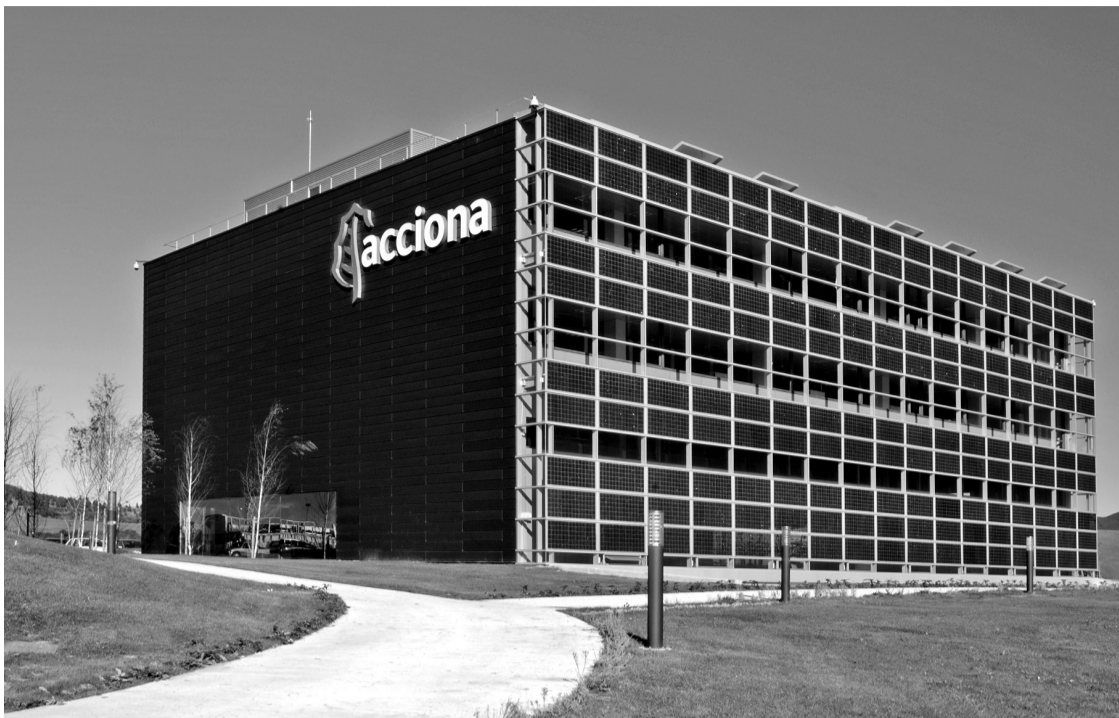
UBICACIÓN. El edificio de Acciona está ubicado en la Ciudad de la Innovación de Sarriguren, cerca de Pamplona
