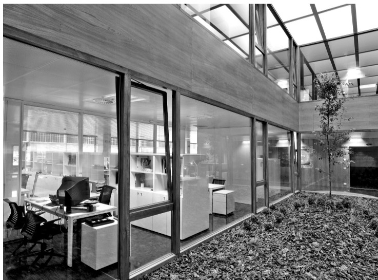
INTERIOR. El jardín interior acristalado es esencial para favorecer la entrada de luz natural
