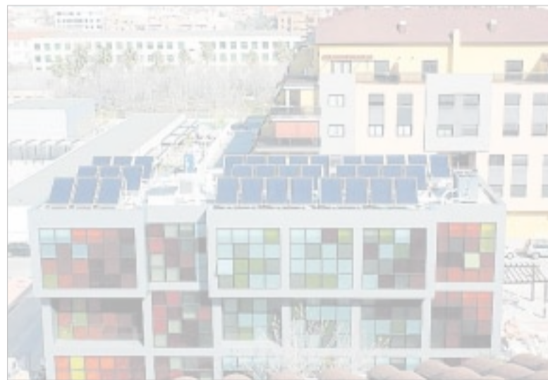
Exterior del edificio de la Mancomunidad de La Ribera. ISER
